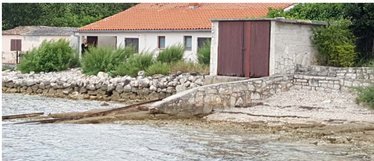
Slika 3: Postojeća kuća rubno uz južnu granicu obuhvata
