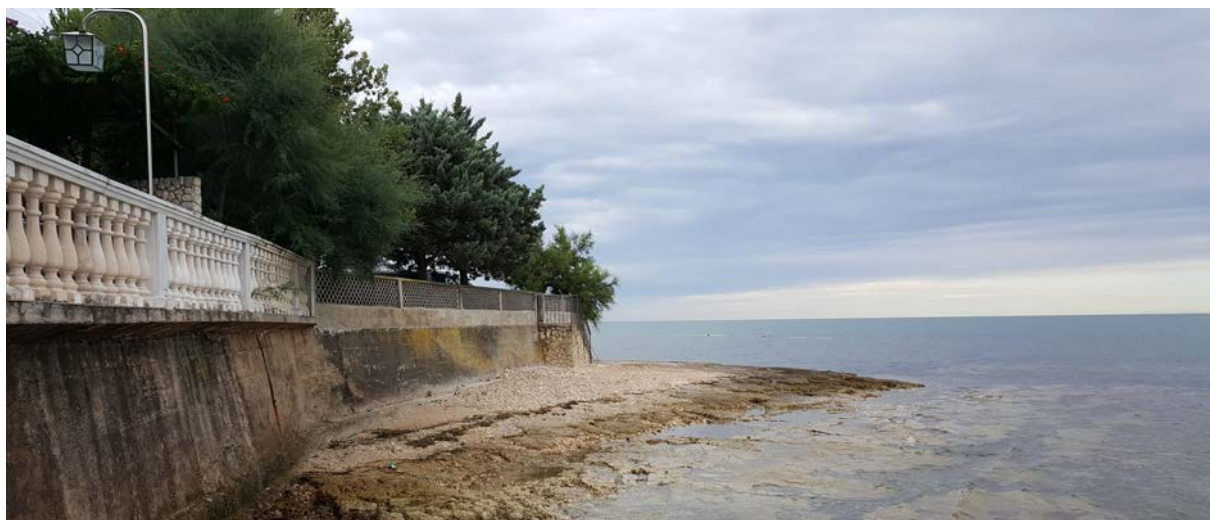
Slika 2: Postojeći obalni zid uz južni rub obuhvata
