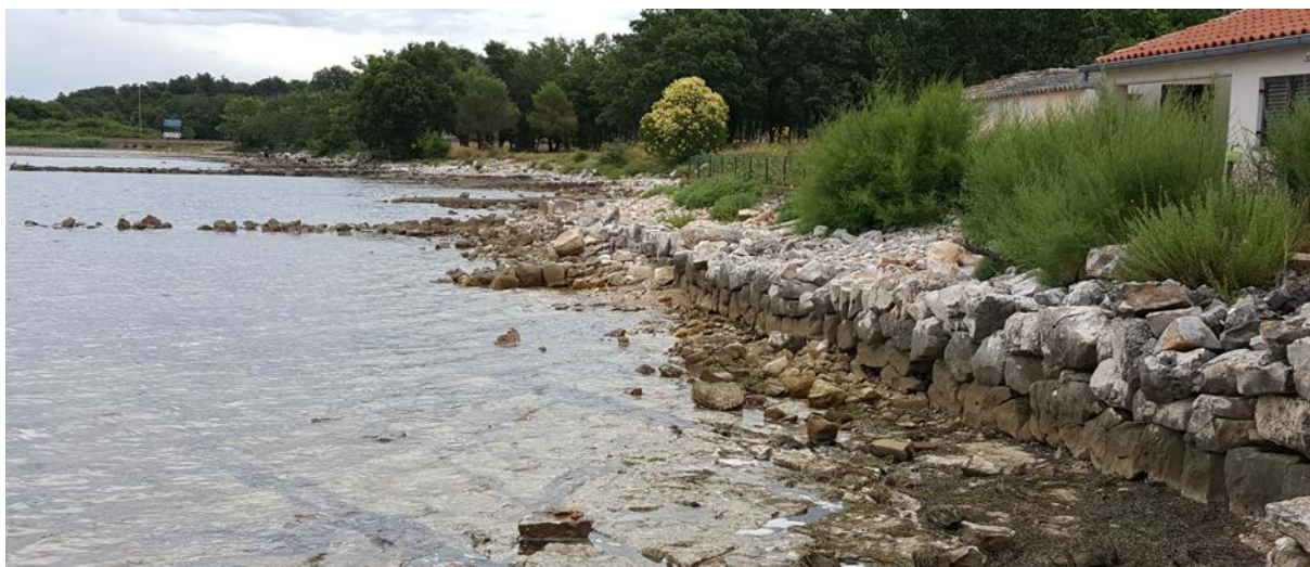
Slika 4: Postojeći kameni obalni zid - suhozid
